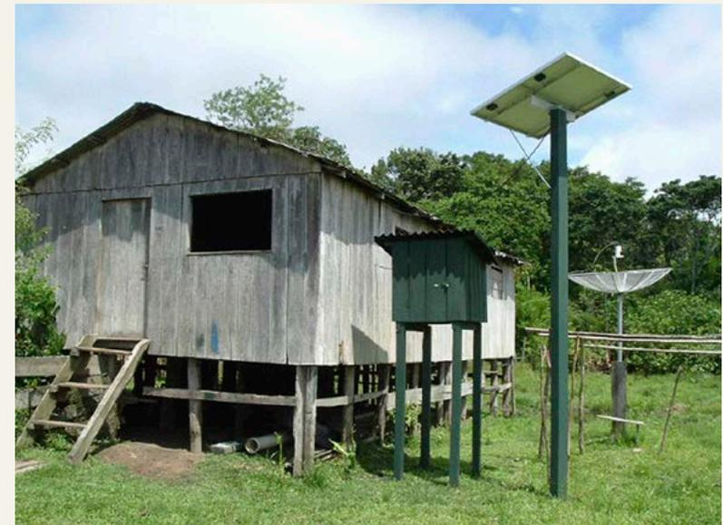
Sistema Individual de Generación de Energía Eléctrica por Fuentes de Energía Intermitentes, desarrollado para el servicio de energía rural, que sirve de referencia para los concesionarios de energía en la aplicación del Programa Luz para Todos, del Ministerio de Minas y Energía (MME), definido por la Ley de Universalización del servicio de energía eléctrica en Brasil (Ley nº 10.438/2002).
