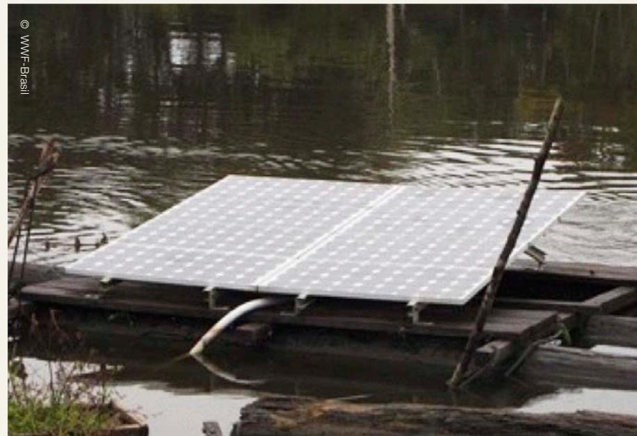
**Foto 6** – Sistema de bombeo en superficie en la Reserva de Desenvolvimento Sustentável Mamirauá.
