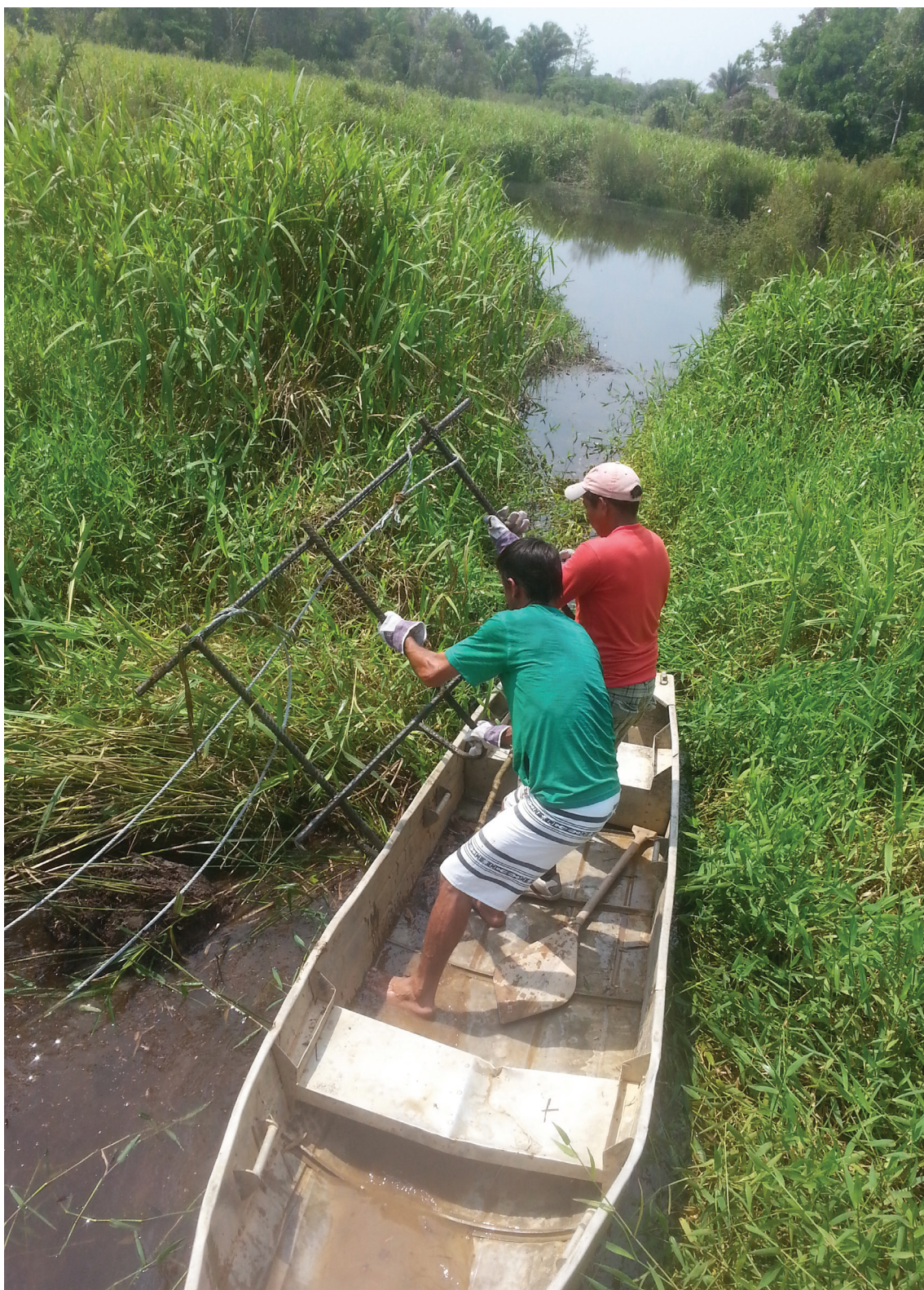
Garfo de ferro utilizado na desobstrução do igarapé Santa Rosa
