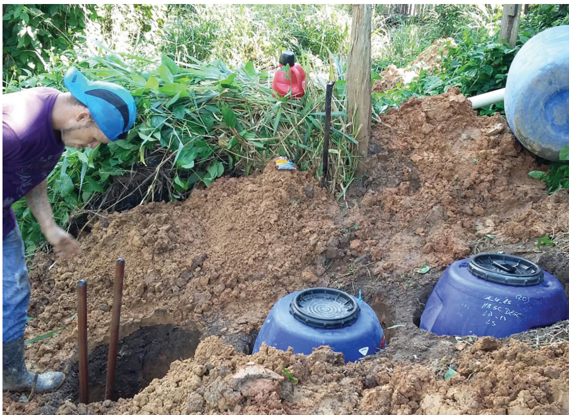
Instalação das fossas sépticas econômicas na zona urbana de Xapuri
