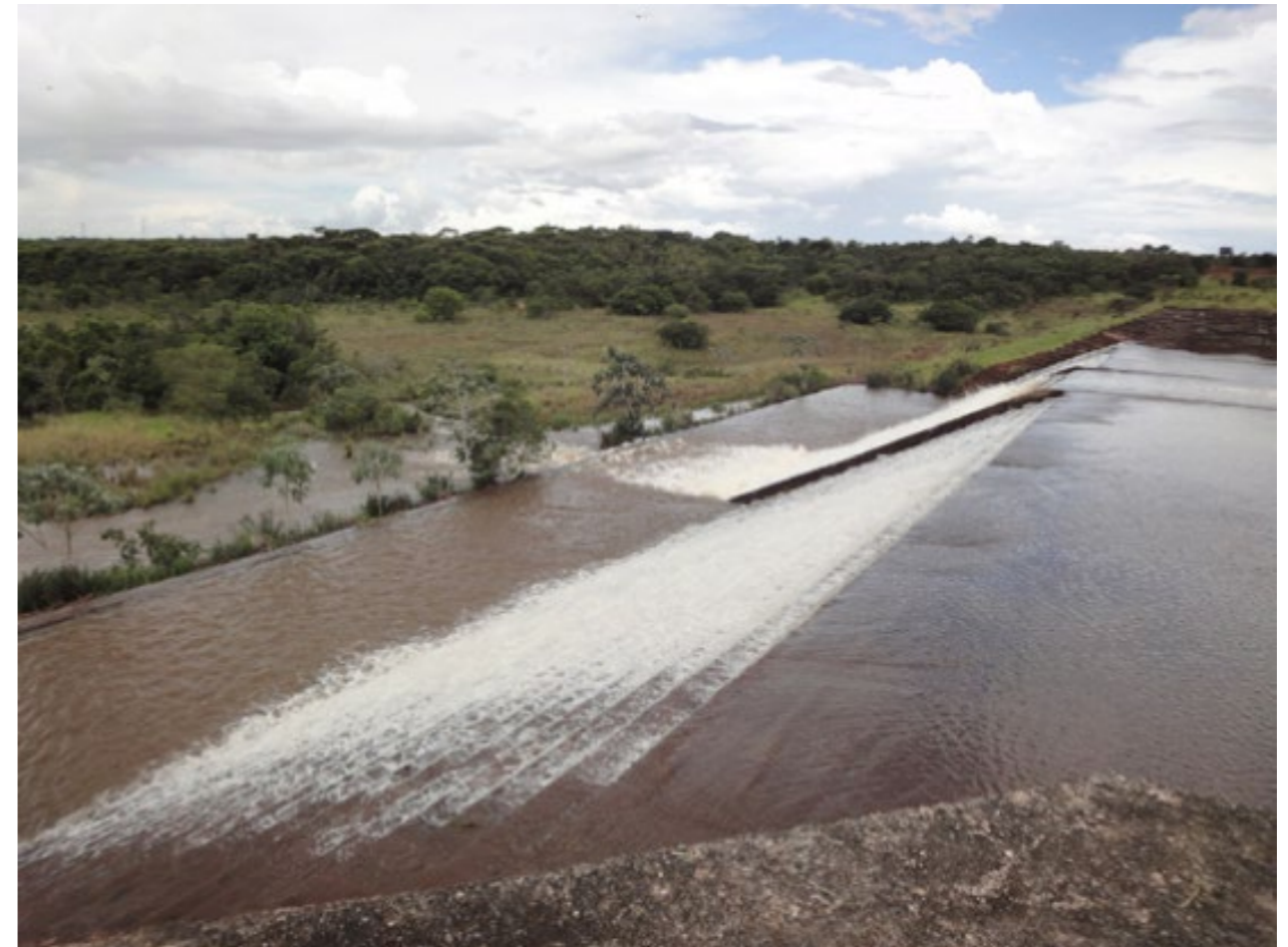
Figura 18. Barragem de derivação do Sistema Guariroba
